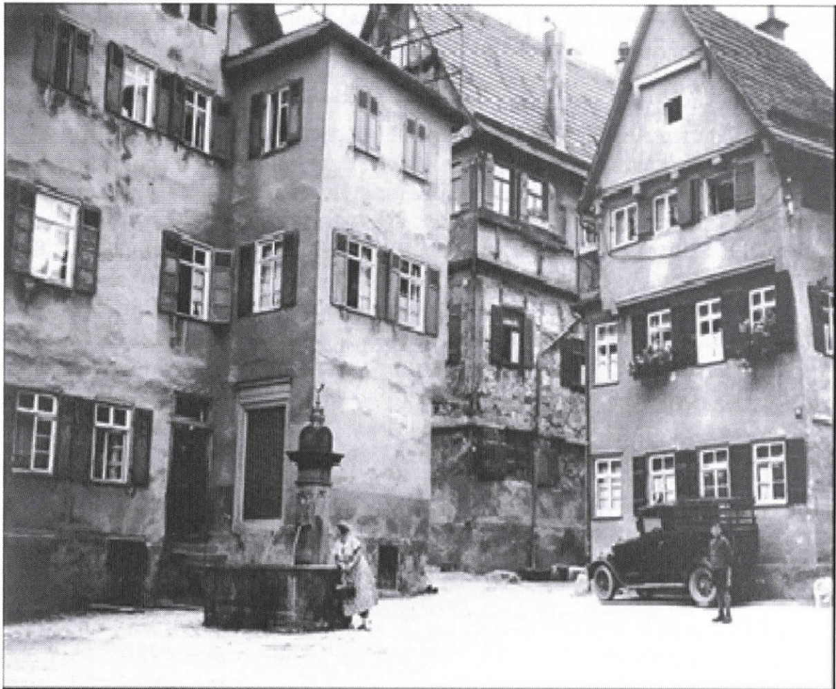
Abb. 45 Bad Urach, Das abgebrochene Gebäude [118] vor dem Haus am Gorisbrunnen. Der namensgebende Brunnen steht damals noch an seinem ursprünglichen Standort knapp unterhalb des für Futtermauer (100) zu rekonstruierenden Verlaufs. Aufnahme gg. Süden (nach Strähle 2015).
